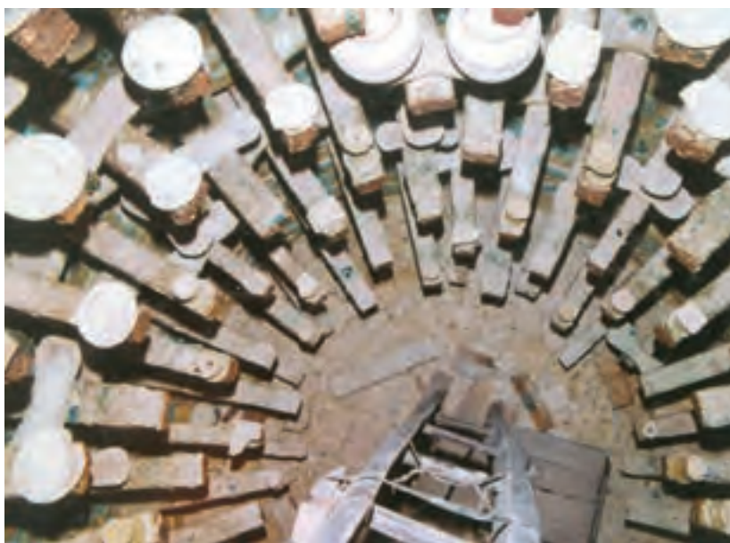
تصویر ۴- داخل یک کوره سنتی گازی
