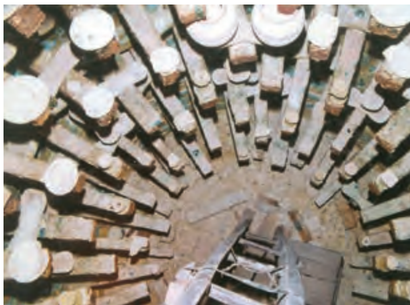
تصویر ۴- داخل یک کوره سنتی گازی
