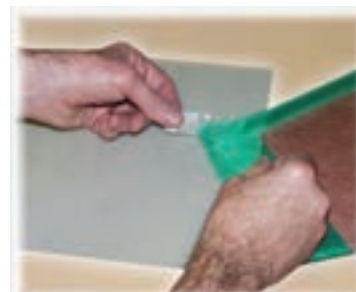
شکل ۳-۱۱- جدا کردن روکش لمینت
