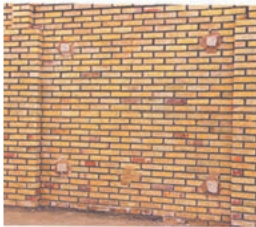
▲ شکل ۲۱-۳ کرم‌بندی ابتدا و انتهای دیوار
