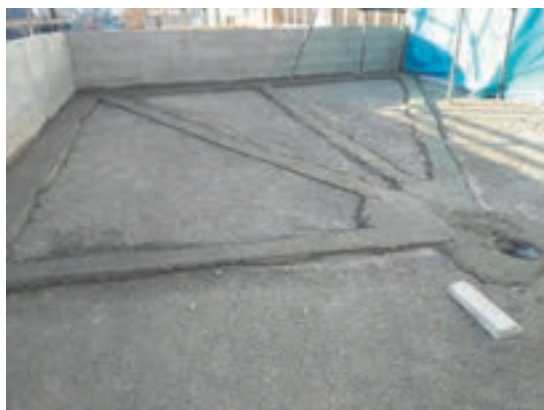
شکل ۵-۱۴ ▲ کرم‌بندی و شمشه‌گیری بین آن‌ها
