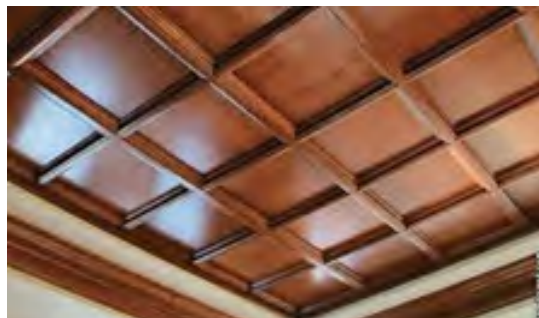
سقف کاذب مشبک چوبی
