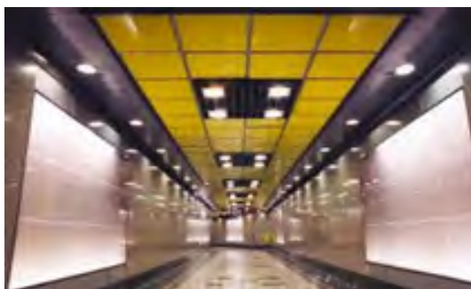
سقف کاذب تایل آلومینیومی با شبکه فلزی
