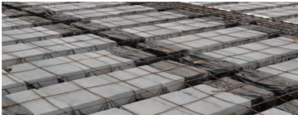
اجرای شناژ مخفی در سقف تیرچه بلوک
