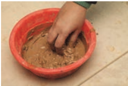
شکل ۱۱- تهیه گل یکنواخت با دوغاب
