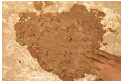
شکل ۱۱- تهیه گل یکنواخت با دوغاب
