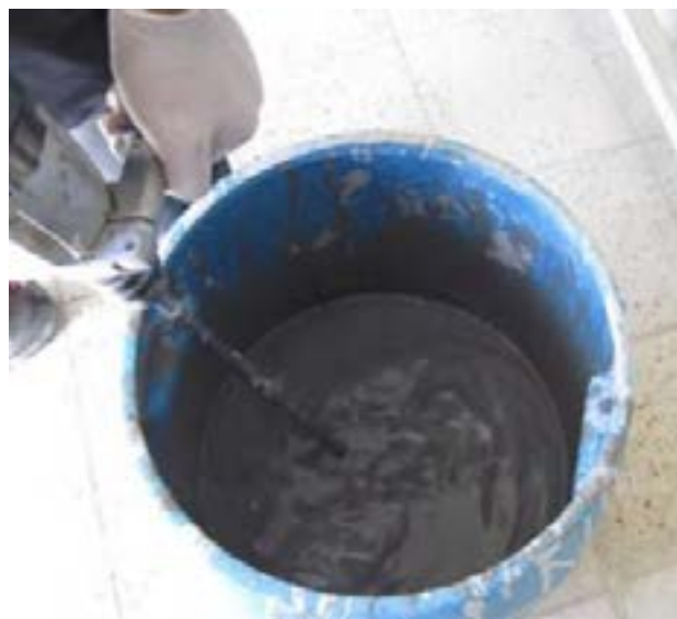
شکل ۱۸- هم زدن دوغاب قبل از ریخته‌گری
