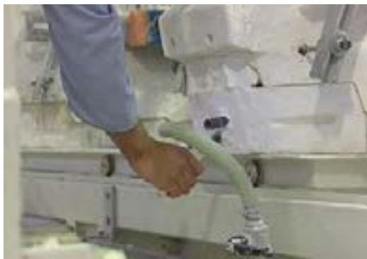
شکل ۳۵- باز کردن لوله‌ها جهت تخلیه دوغاب اضافی
