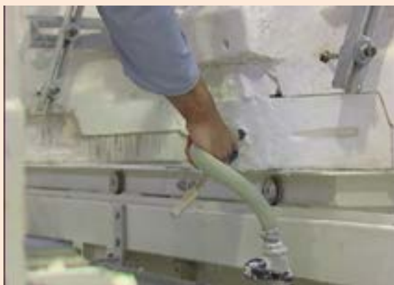
شکل ۲۵- مجرای زیر قالب جهت تخلیه دوغاب
