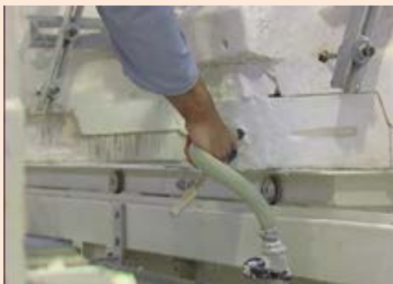
شکل ۲۵- مجرای زیر قالب جهت تخلیه دوغاب
