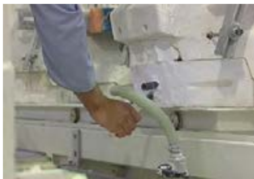
شکل ۳۵- باز کردن لوله‌ها جهت تخلیه دوغاب اضافی
