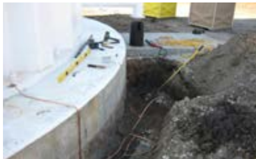
شکل ۴-۲۳ تخلیه الکتریسیته ساکن بدنه مخزن به زمین
