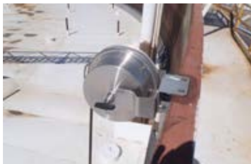
شکل ۴-۲۴ تخلیه الکتریسیته ساکن در مخزن سقف شناور
