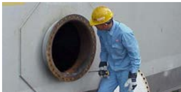
شکل ۱۹-۴- دریچه آدم رو مخزن
