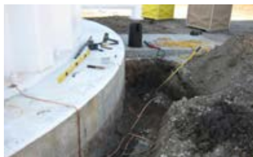
شکل ۴-۲۳ تخلیه الکتریسیته ساکن بدنه مخزن به زمین
