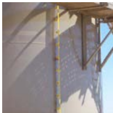
شکل ۲۰-۴ ارتفاع سنج مغناطیسی روی مخزن
