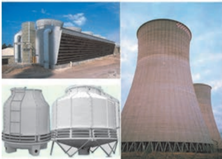
شکل ۸-۲- انواع برج های خنک کننده مرطوب
