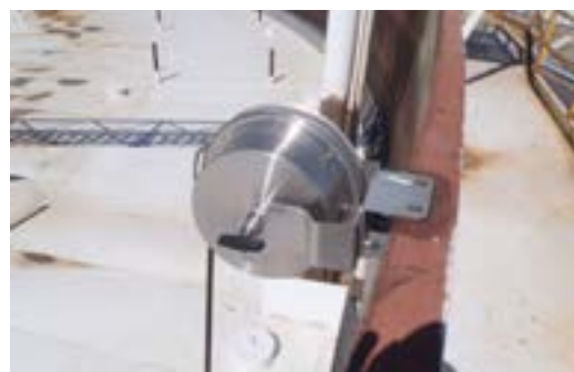
شکل ۴-۲۴ تخلیه الکتریسیته ساکن در مخزن سقف شناور
