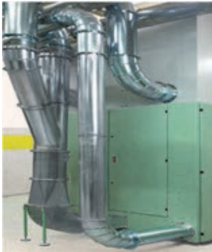
شکل ۱-۳۴ نمونه اتصالات شوت فید
