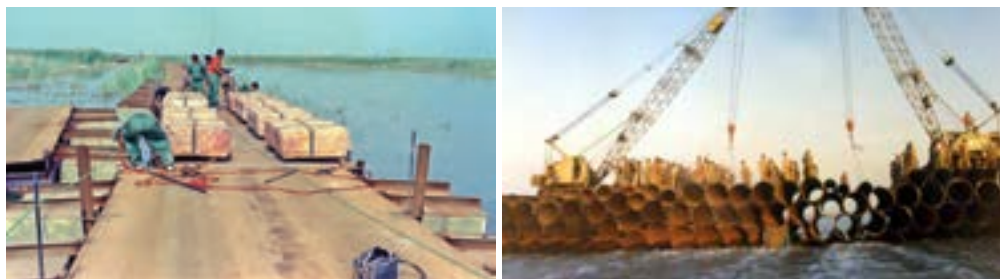
شکل ۶-۱- تصاویری از مراحل آمادگی، نصب و آماده‌سازی پل خیبر
