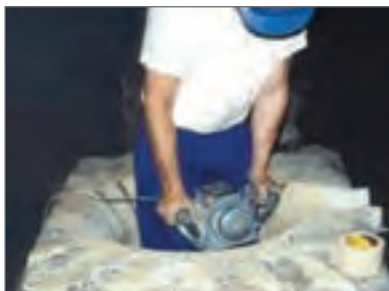
شکل ۱۳- کوبیدن نسوز کف کوره با کوبه ماشینی
