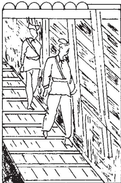
شکل ۴-۱۶- گذرگاه مخصوص کارگران (۶)
