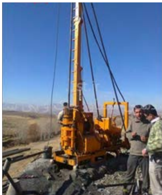
دستگاه حفاری مستقر شده بر روی فونداسیون
