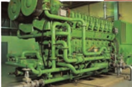
موتور ژنراتور یک نیروگاه برق اضطراری معدن
