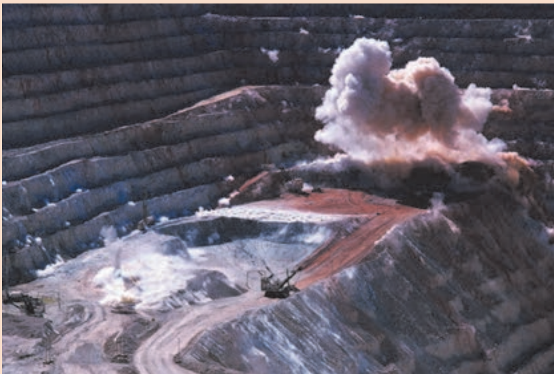
عملیات چال‌زنی و آتشکاری در معدن
