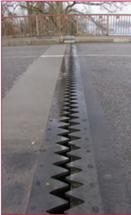
شکل ۲۳-۲. فاصله دندانهای شکل بین دو قسمت پل
