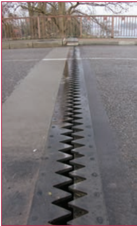
شکل ۲۳-۲. فاصله دندانهای شکل بین دو قسمت پل
