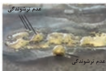
شکل (۶-۲۲) عدم ترشوندگی سطح فلز را به دلیل سرد بودن درز اتصال نشان می دهد.
