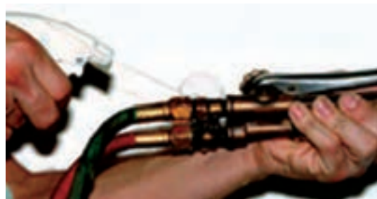
شکل ۳-۳۷- اسپری کردن محلول نشتی‌یاب روی اتصالات
