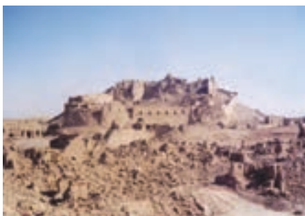
ج) ارگ بم بعد از زلزله
