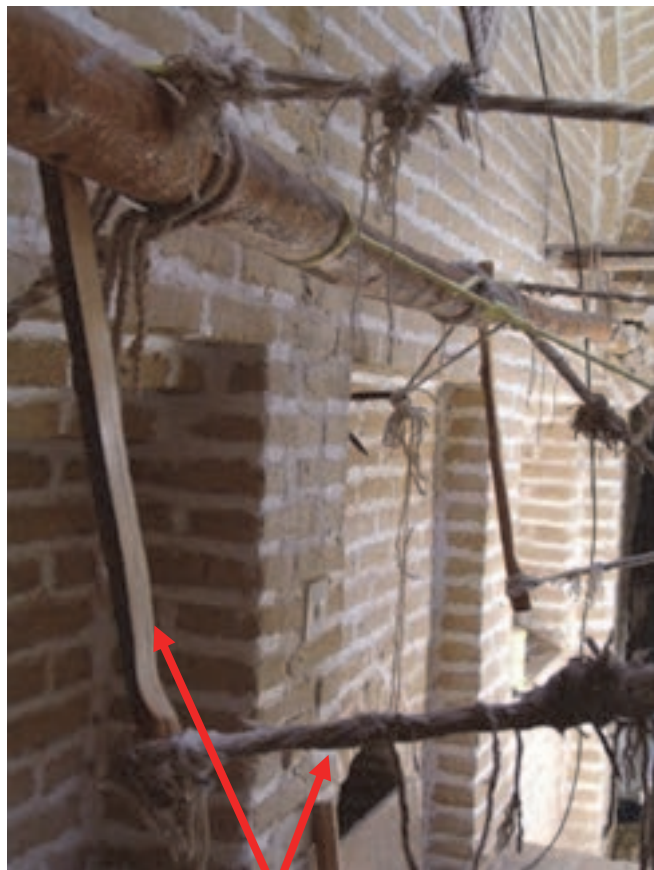
شکل ۳۶- کُمونِه و نخ اتصال آن
