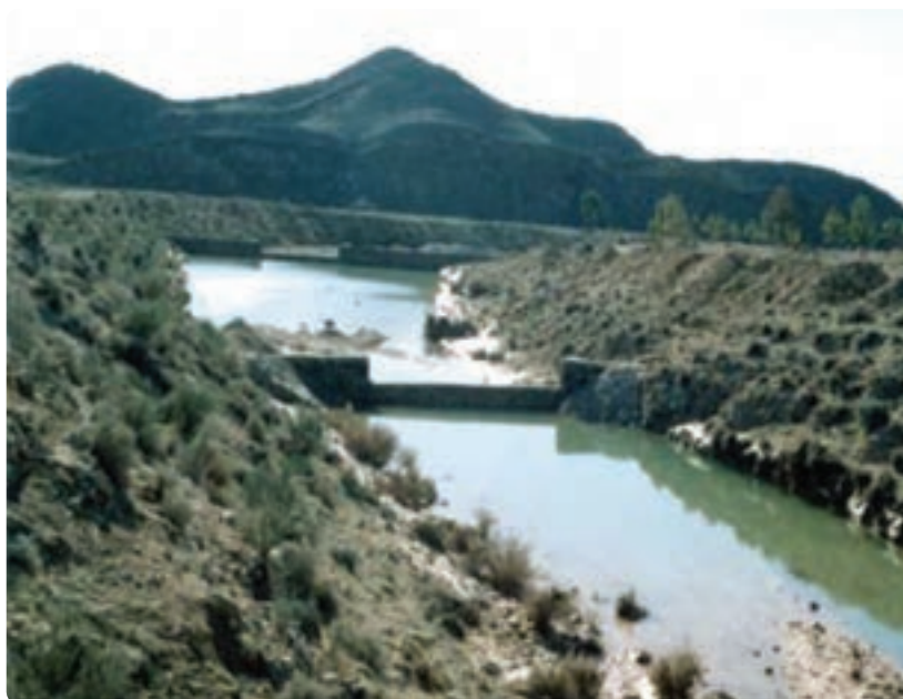
شکل ۳۱-۱- حفاظت خاک و کنترل رسوب در اطراف سد سلمان فارسی
