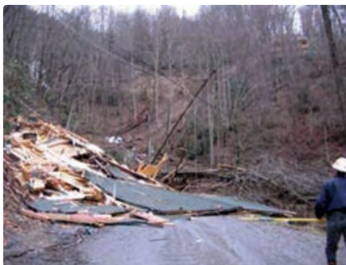
شکل ۱۲-۱- تخریب ناشی از رانس زمین
