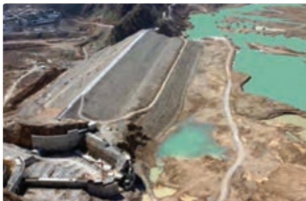
شکل ۱-۲۵- احداث سد سیوند بر روی رود سیوند
