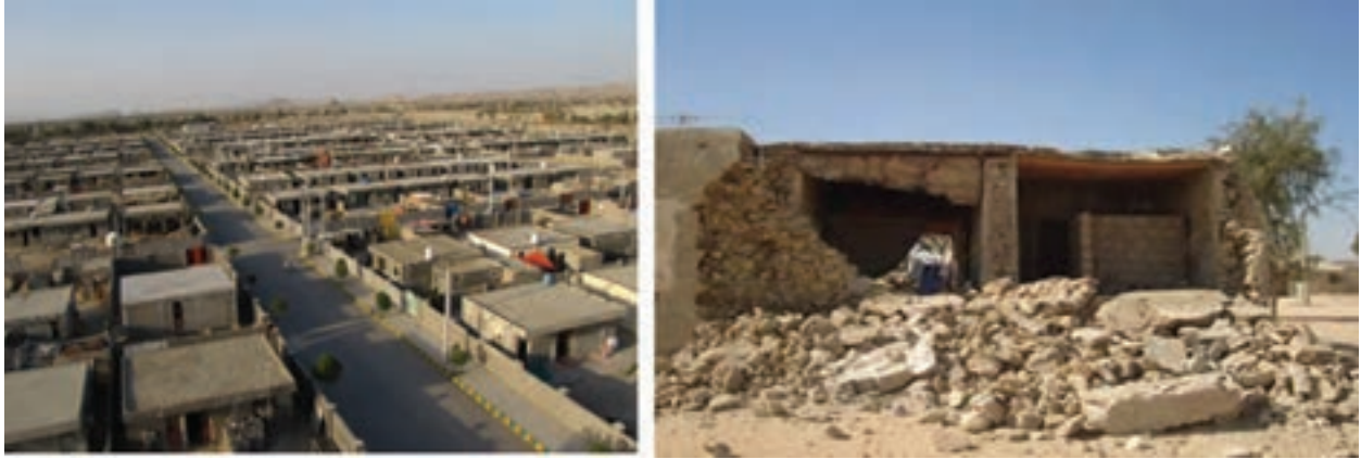
شکل ۶۰-۱- زلزله در شهرستان قشم
