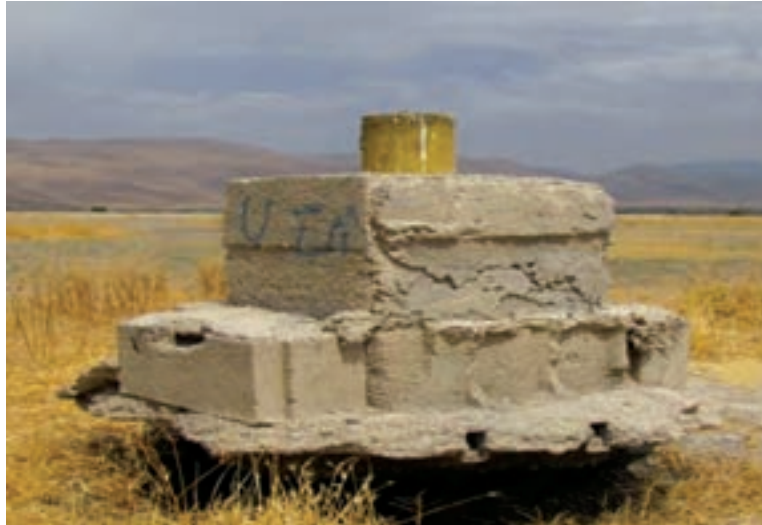
تصویر ۸-۴- پدیده فرونشست زمین (منطقه خانمیرزا)
