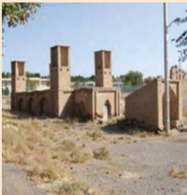
شکل ۳-۴- آب انباری در کوهپایه
