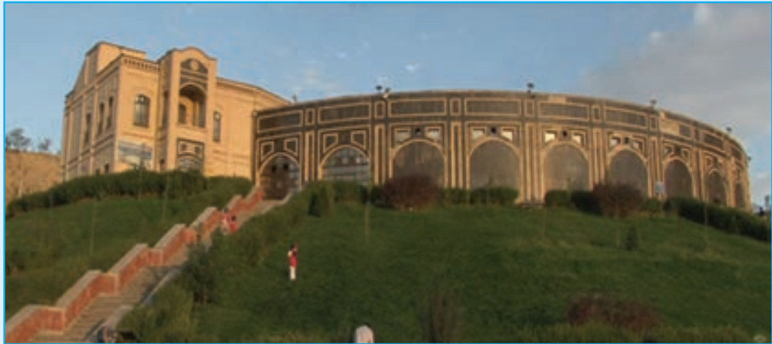
شکل ۴-۵- نمایی از آبگرم بستان آباد
