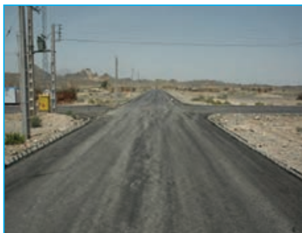
شکل ۹-۱۴- اجرای طرح‌های روستای چگرد خاش
