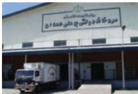
شکل ۲-۶- سردخانه بوعلی - همدان
