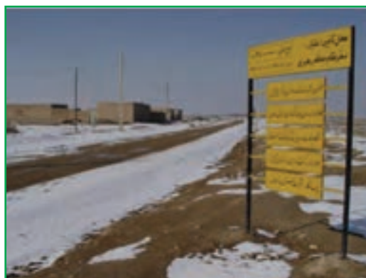
شکل ۶-۶- پروژه احداث راه روستایی - آق تپه
