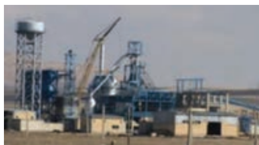
شکل ۴-۶- مجتمع ذوب آهن - اسدآباد
