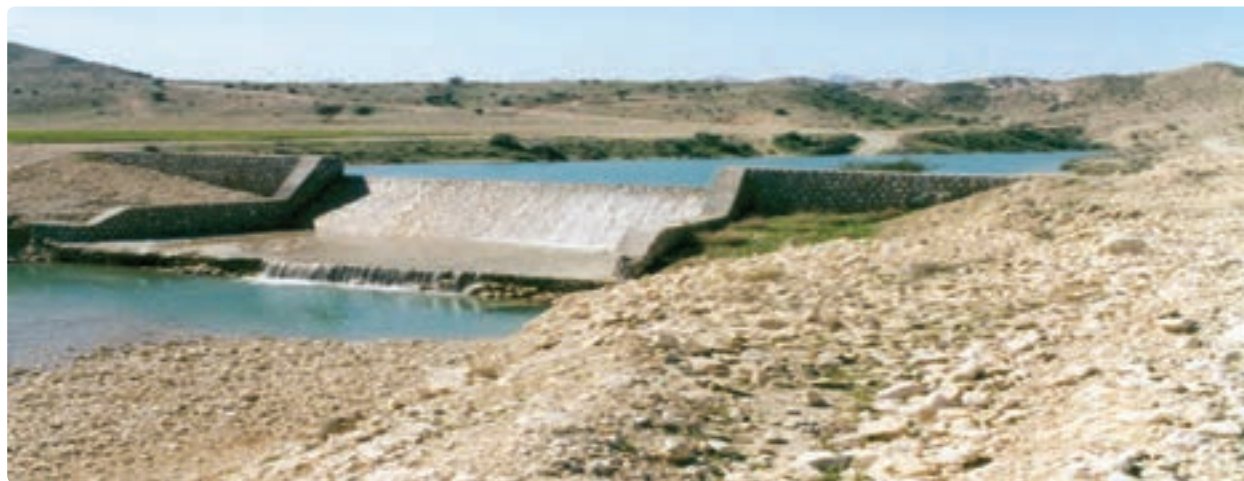
شکل ۱۳-۱۴- احداث استخرهای ذخیره آب
