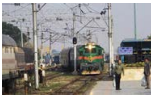
شکل ۲۴ - ایستگاه راه آهن ساری
