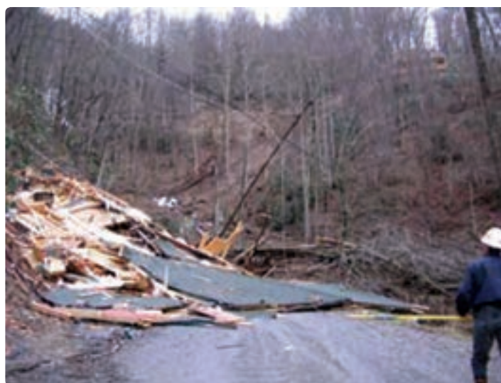
شکل ۱۲-۱- تخریب ناشی از رانس زمین
