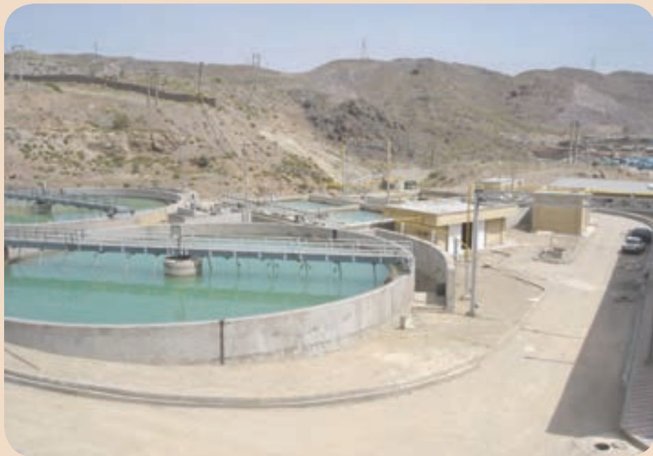
شکل ۱-۶۰- تصفیه خانه مجتمع مس سرچشمه
