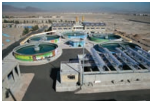
شکل ۱۳-۴- تصفیه خانه آب زاهدان
