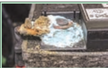
شکل ۱۶-۱- سولفات شده قطب‌های باتری
