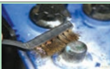
شکل ۱۷-۱- تمیز کردن قطب‌ها با برس سیمی
