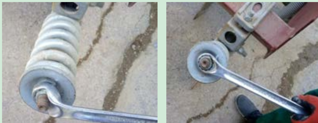
شکل ۴۵- آچارکشی نقاط اتصال اجزا و قطعات
