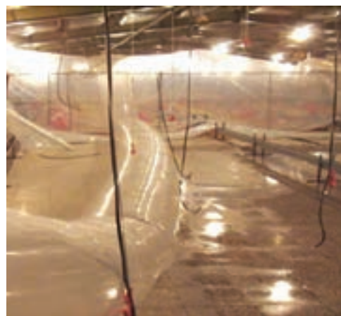
۳ کانال پلاستیکی هوای گرم در روی زمین
