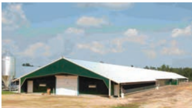
منظره مرغداری قبل از محوطه سازی
