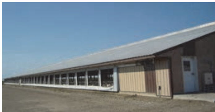
سالن پرورش بوقلمون با دیواره جانبی باز همراه با پرده
