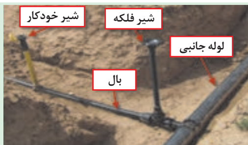
شکل ۱۳-۵. محل شیر فلکه روی بال
