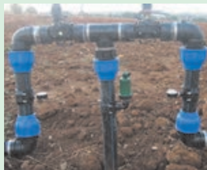
شکل ۳۲-۵. شیر و فشار سنج روی بال ها
