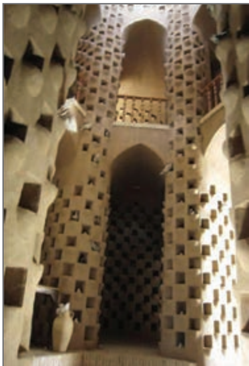
تصویر شماره ۲-۴۷- نمای داخلی برج‌های کبوترخانه
