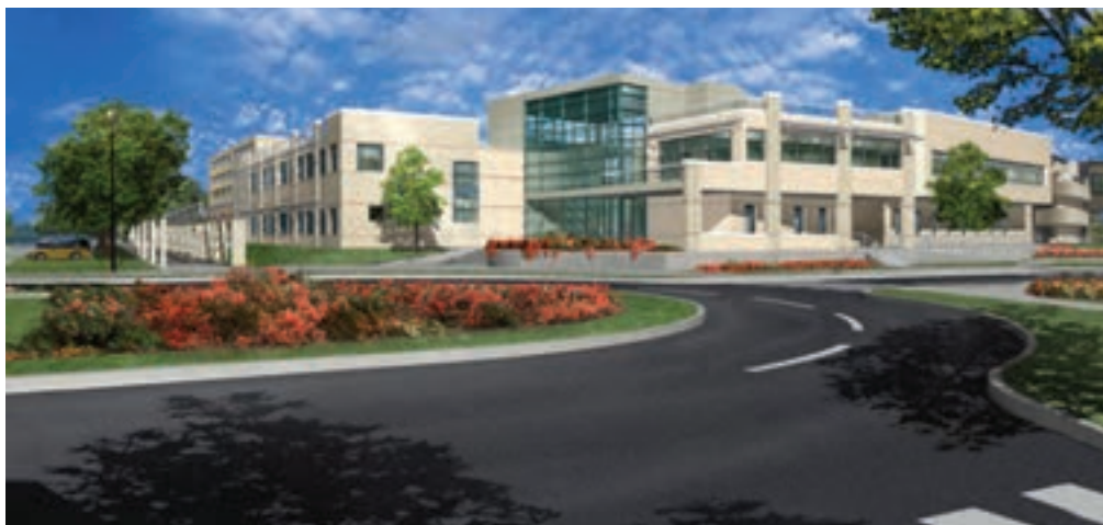
تنوع مصالح و روش‌های اجرای ساختمان و محوطه در یک ساختمان جدید
