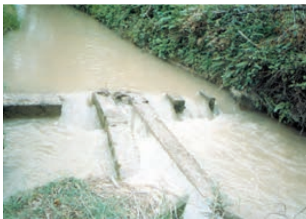
شکل ۸-۲ - مقسم ثابت
