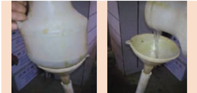
ریختن اسید داخل مبدل جهت رسوب‌زدایی
