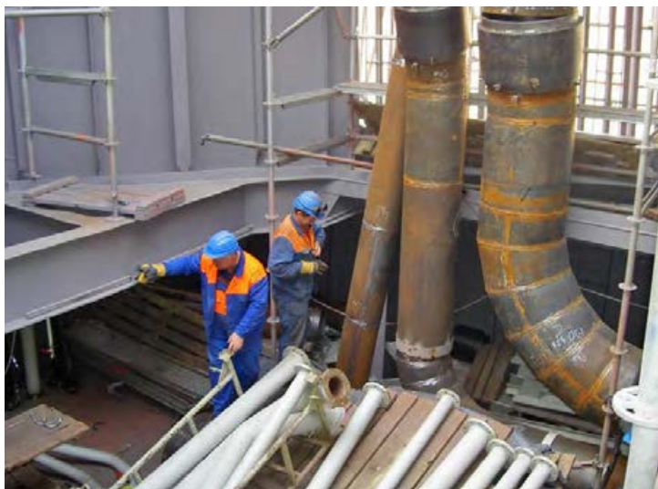
شکل ۷- در حال اجرای لوله‌کشی کشتی
