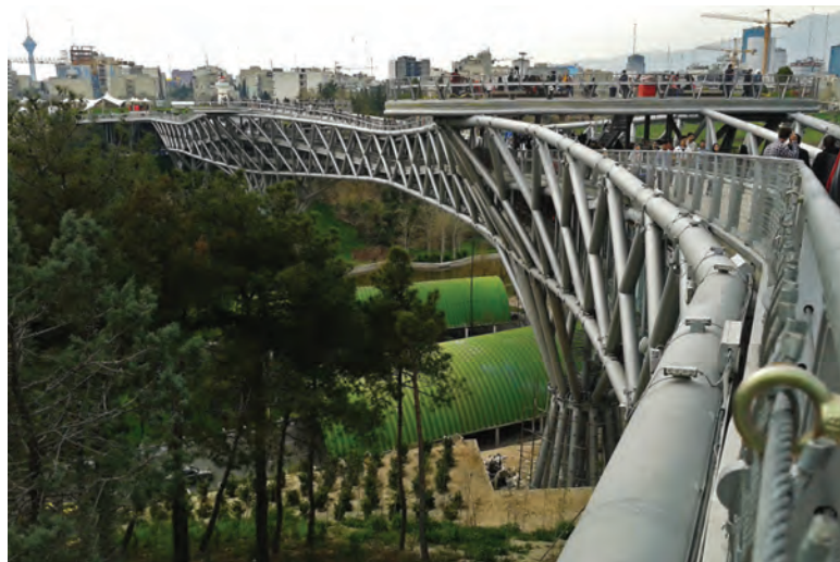
شکل ۲- سازه پل طبیعت
