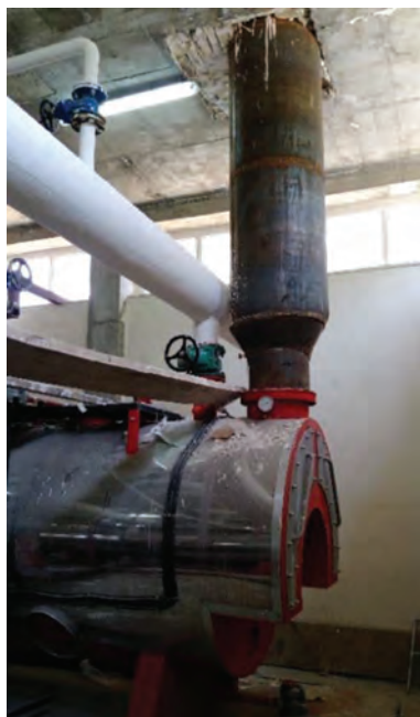
دودکش فلزی دیگ فولادی
