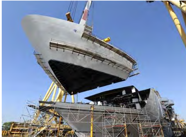
شکل ۸- کیلینگ کردن بلوک‌های کشتی
